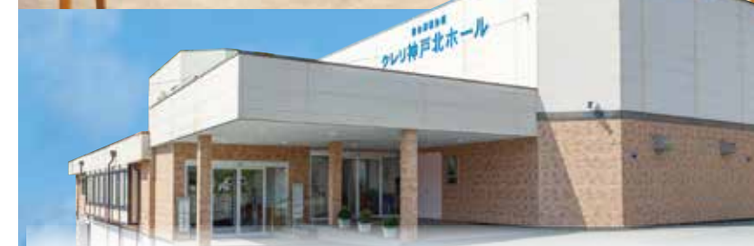
クレリ神戸北ホール外観
